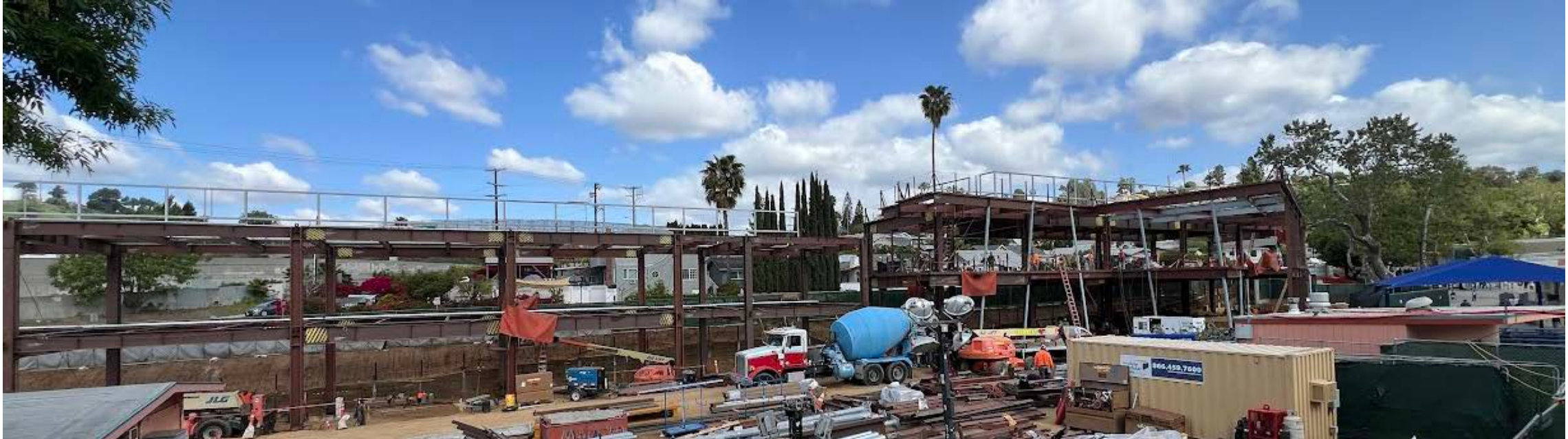
North & South Buildings Steel Structure Progress / Avance de la Estructura de Acero en los Edificios Norte y Sur
