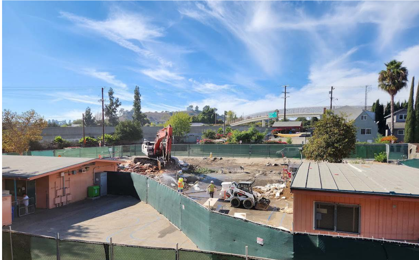
Classroom Building Demolition Progress / Avance de demolición de Aulas
